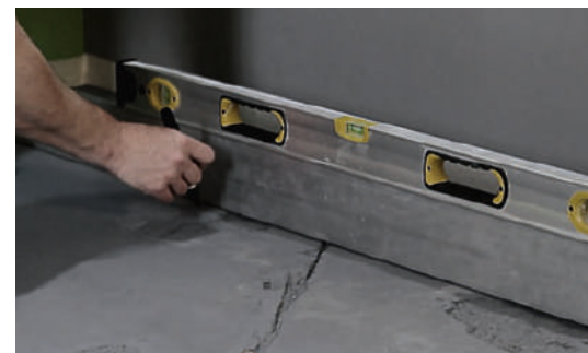
Preparación del soporte. Preparing the support.
