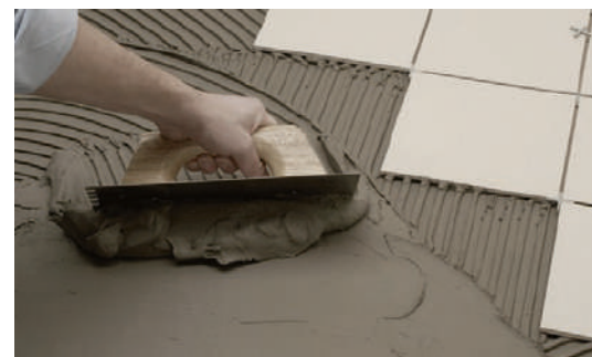
Aplicación del adhesivo. Adhesive material application.
